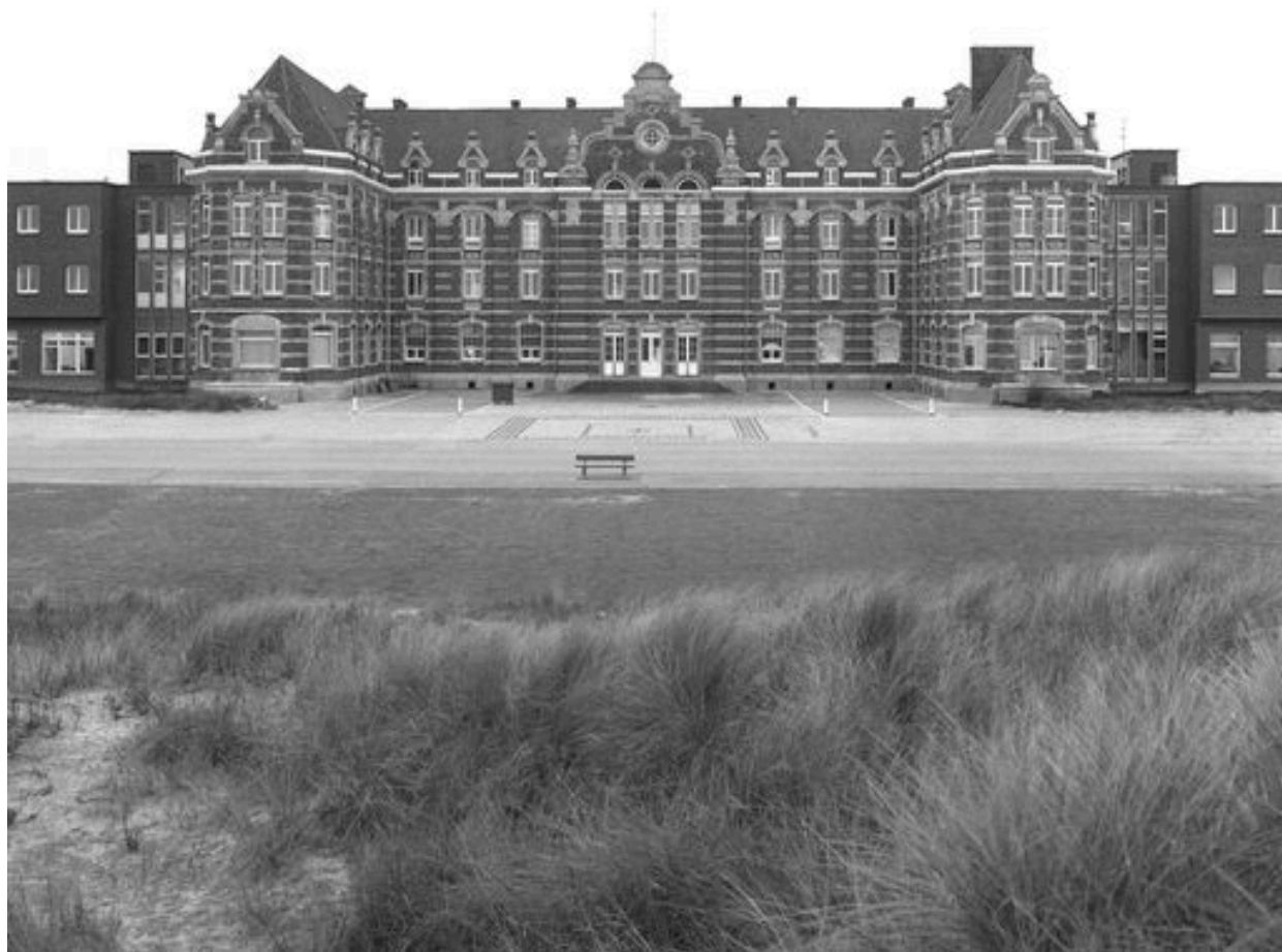
Bâtiment de 450 mètres de longueur dressé face à la mer, façade nord, détail de la partie centrale abritant les services médico-chirurgicaux, vue de face.
