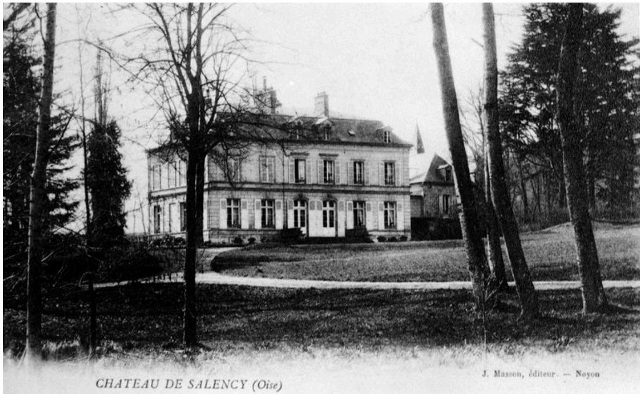
Façade principale du logis, avant 1914 (AP).
