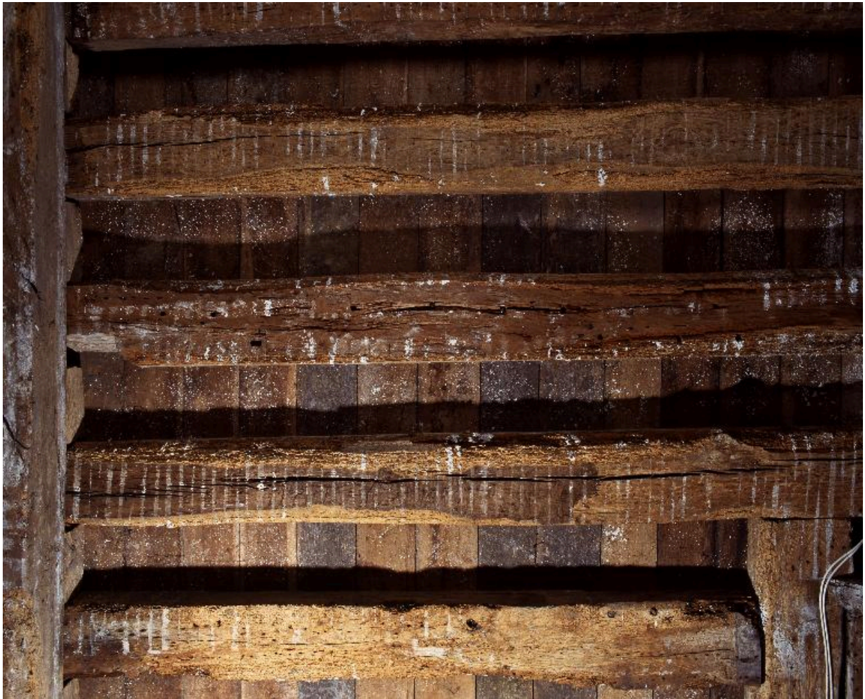
Vue des poutres du plafond de la sacristie.
