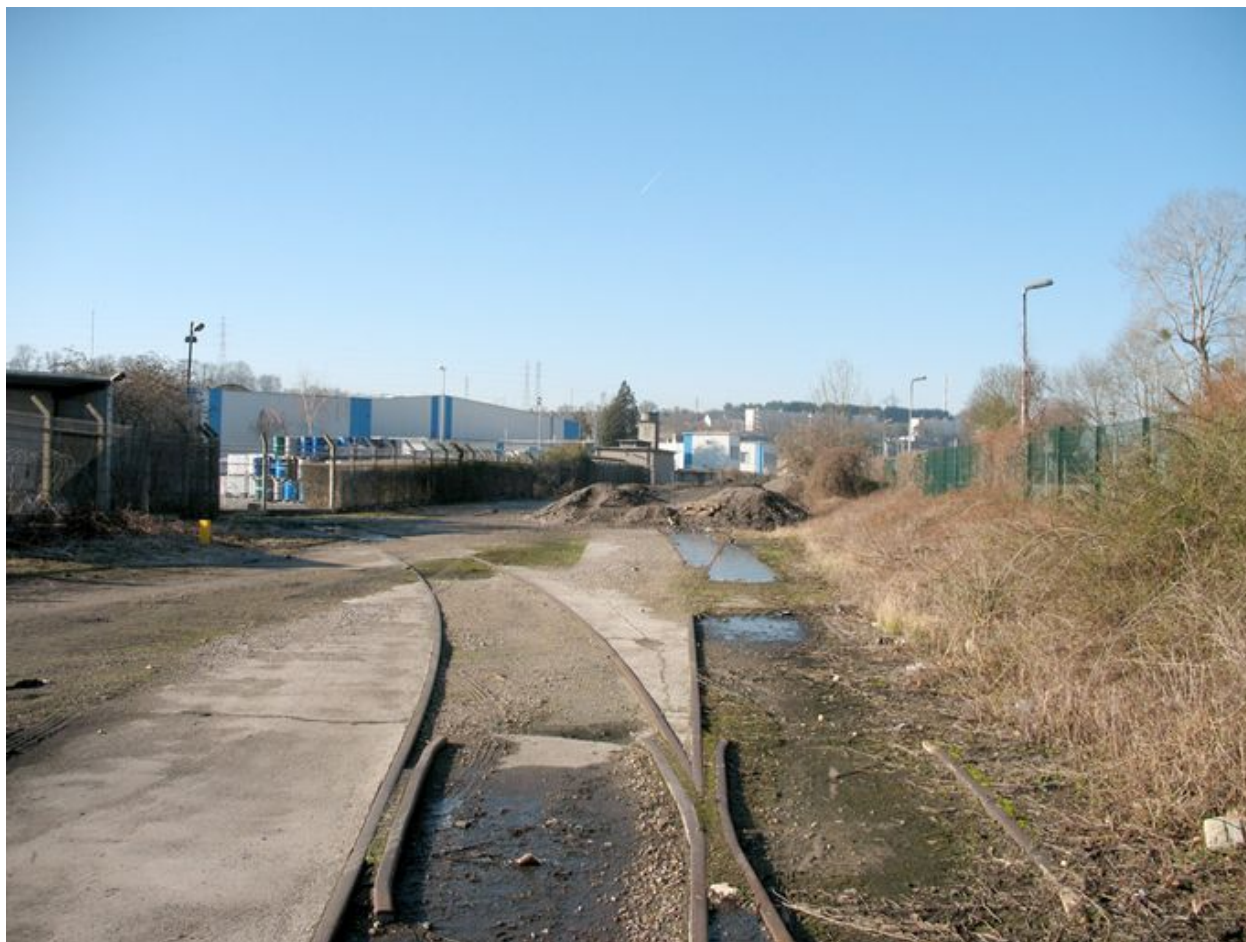
Réseaux de voies ferrées desservant l'usine.
