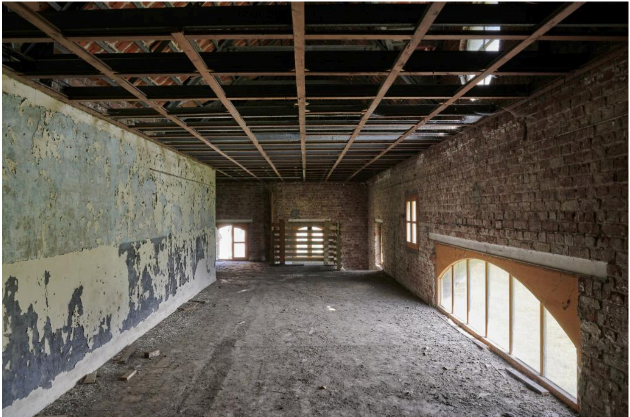
Combles des anciens magasins.
