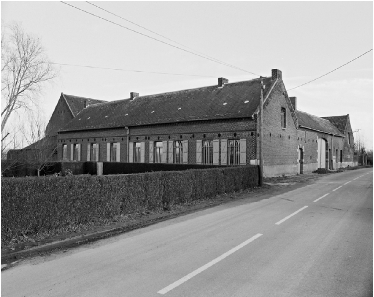
Vue générale de trois quarts de la ferme, côté logis.
