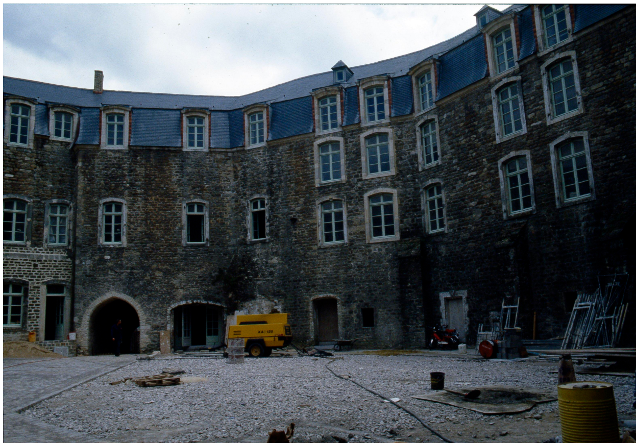
Sur cour d'honneur, façade nord en cours de restauration.
