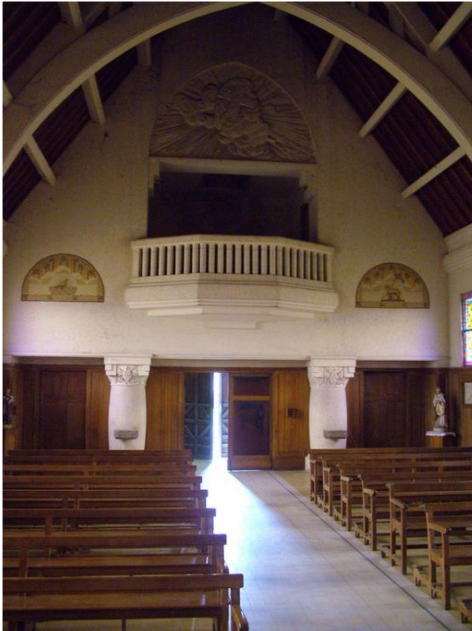
Vue intérieure du mur ouest.
