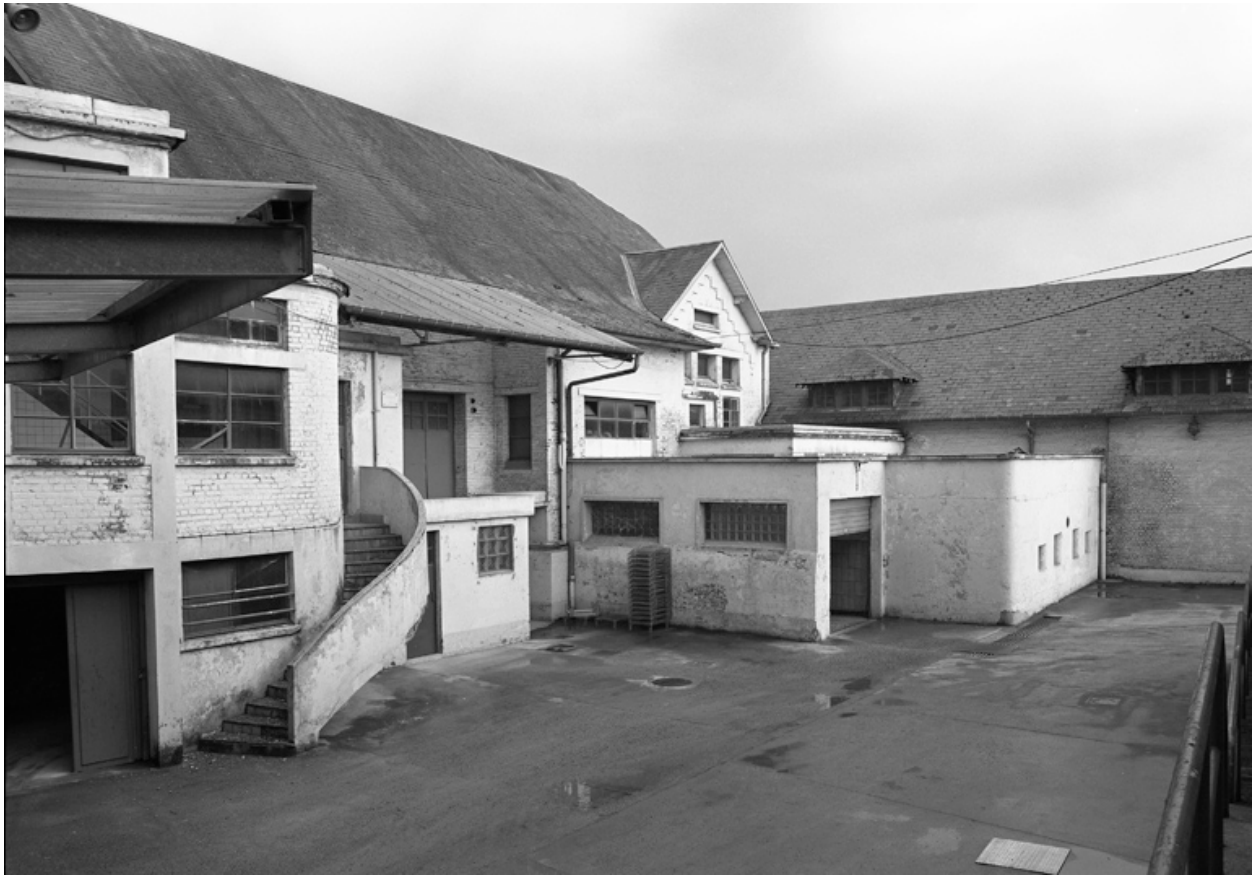
Elévation sur cour des bâtiments de la beurrerie.
