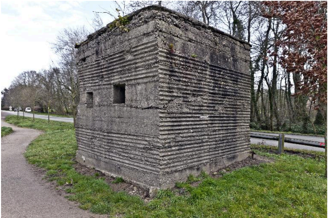
Vue vers le nord-est
