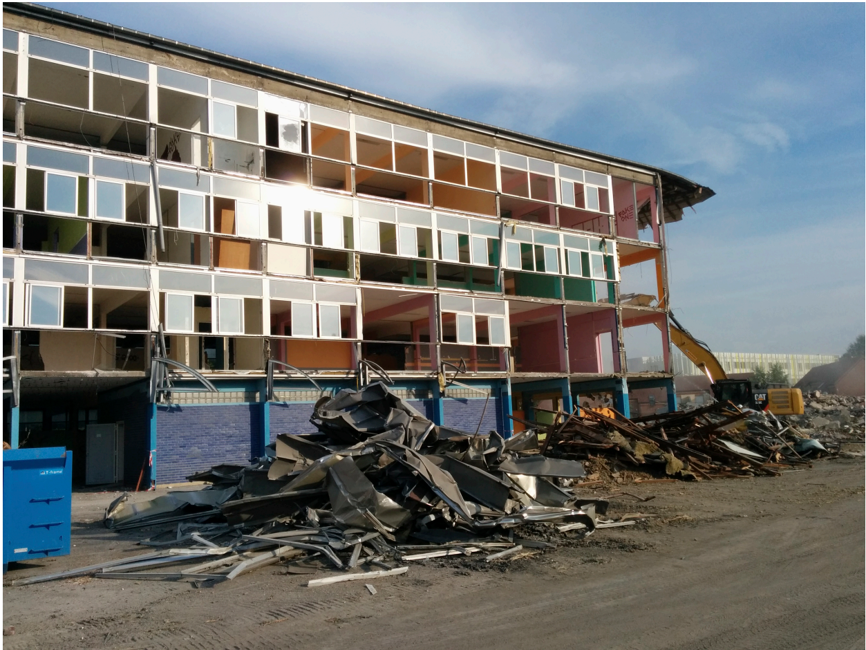
Bâtiment de l'externat en cours de démolition, 2017. (Fonds Conseil Départemental du Nord).
