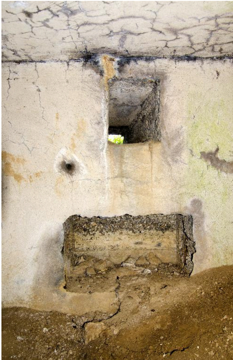
Salle nord. Créneau de fusillade de l'élévation nord (au très grand angulaire)
