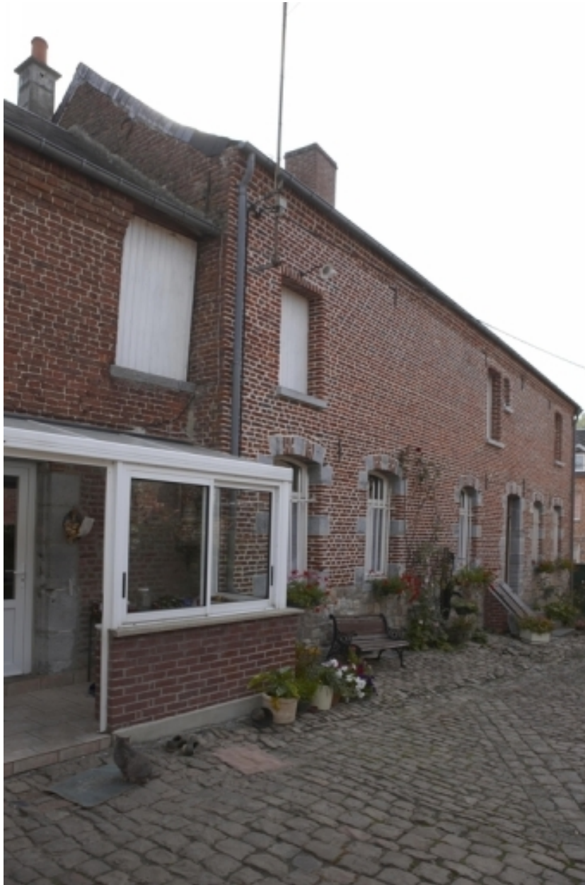
Vue de l'ancienne étable-fenil, transformée en logement.
