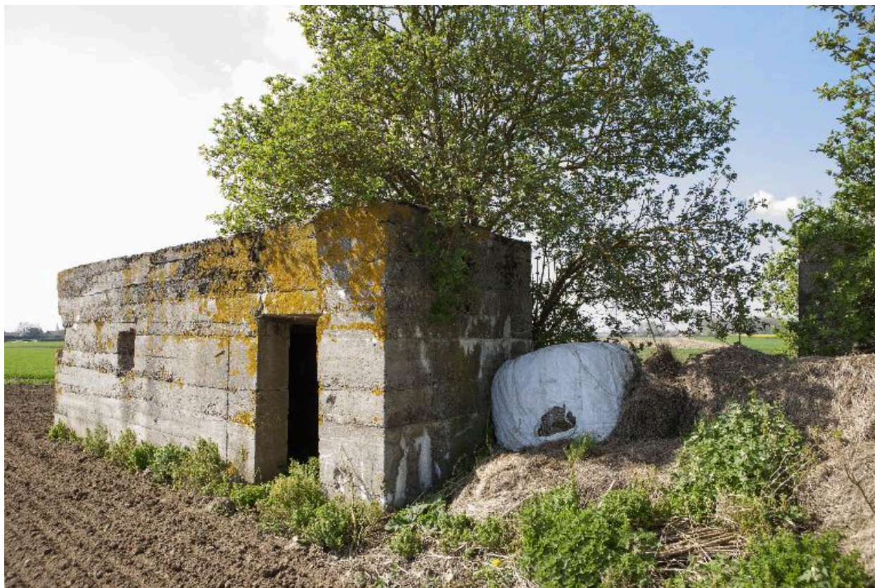
Bâtiment 1 : L'entrée sur élévation ouest
