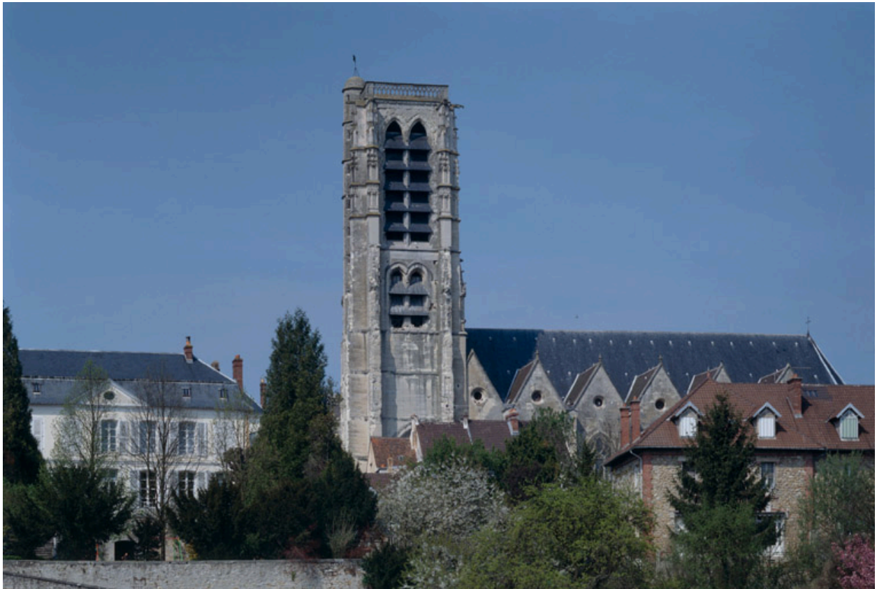
Vue de situation depuis la Marne.
