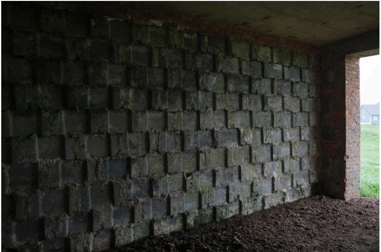
Vue intérieure du bâtiment de montage.
