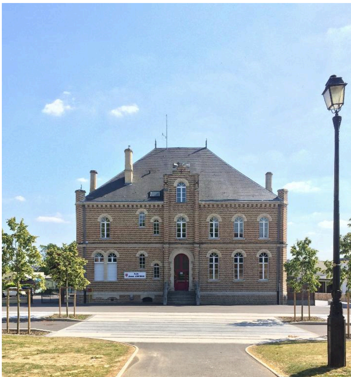
Vue de la façade nord.
