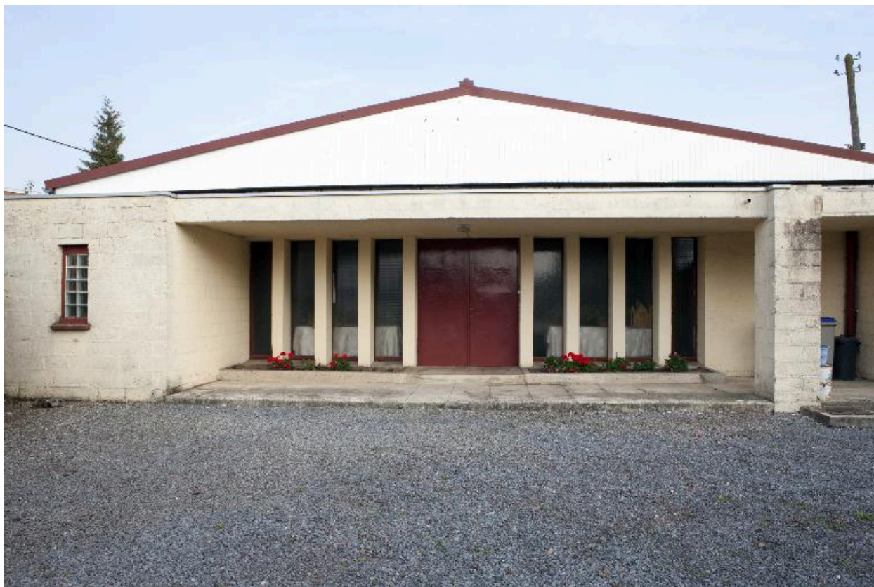
Élévation antérieure de la chapelle.
