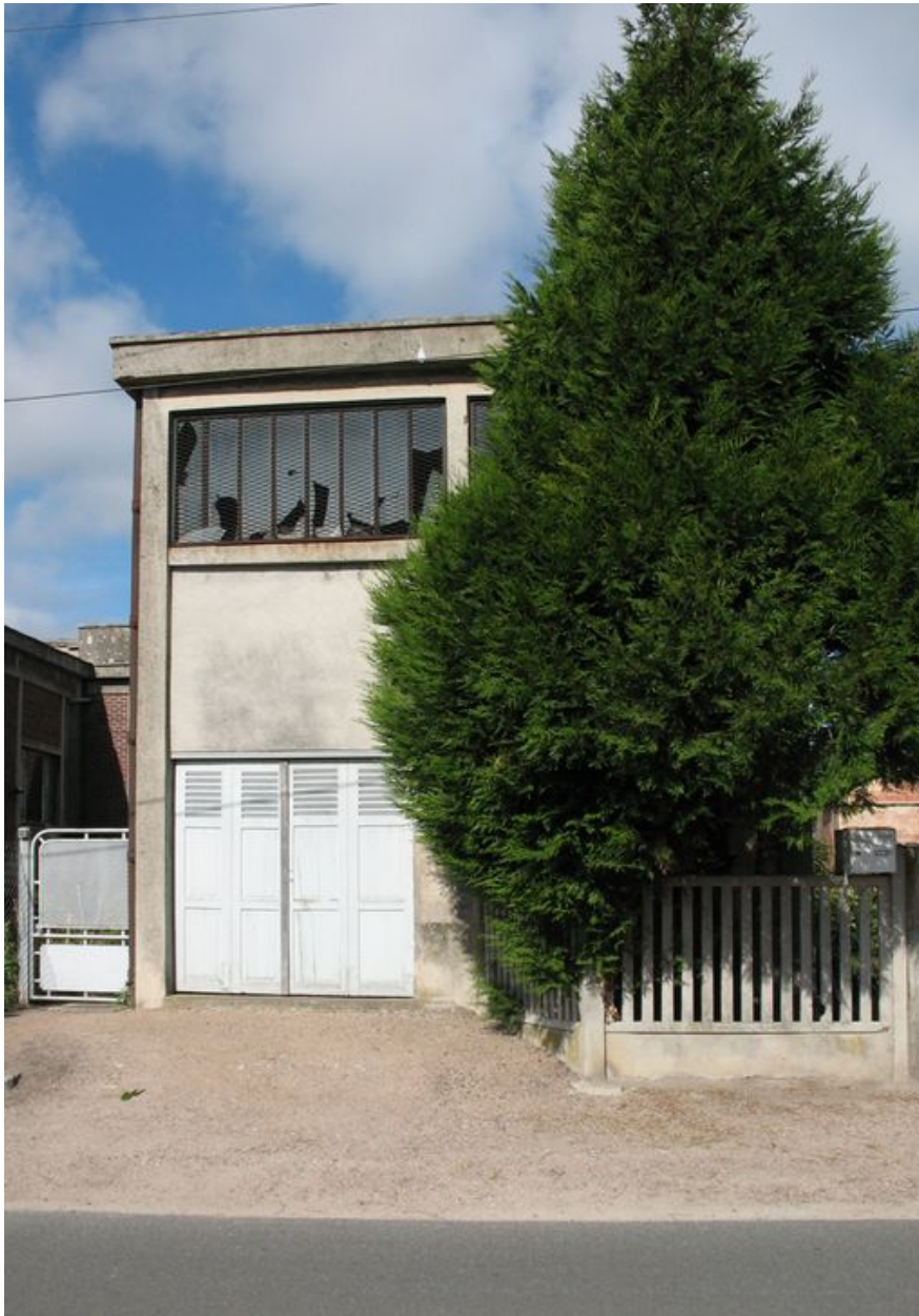
Transformateur électrique de la station de pompage.
