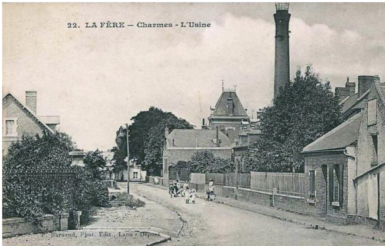
Vue de l'usine depuis la rue. Carte postale, vers 1905 (coll. part.).
