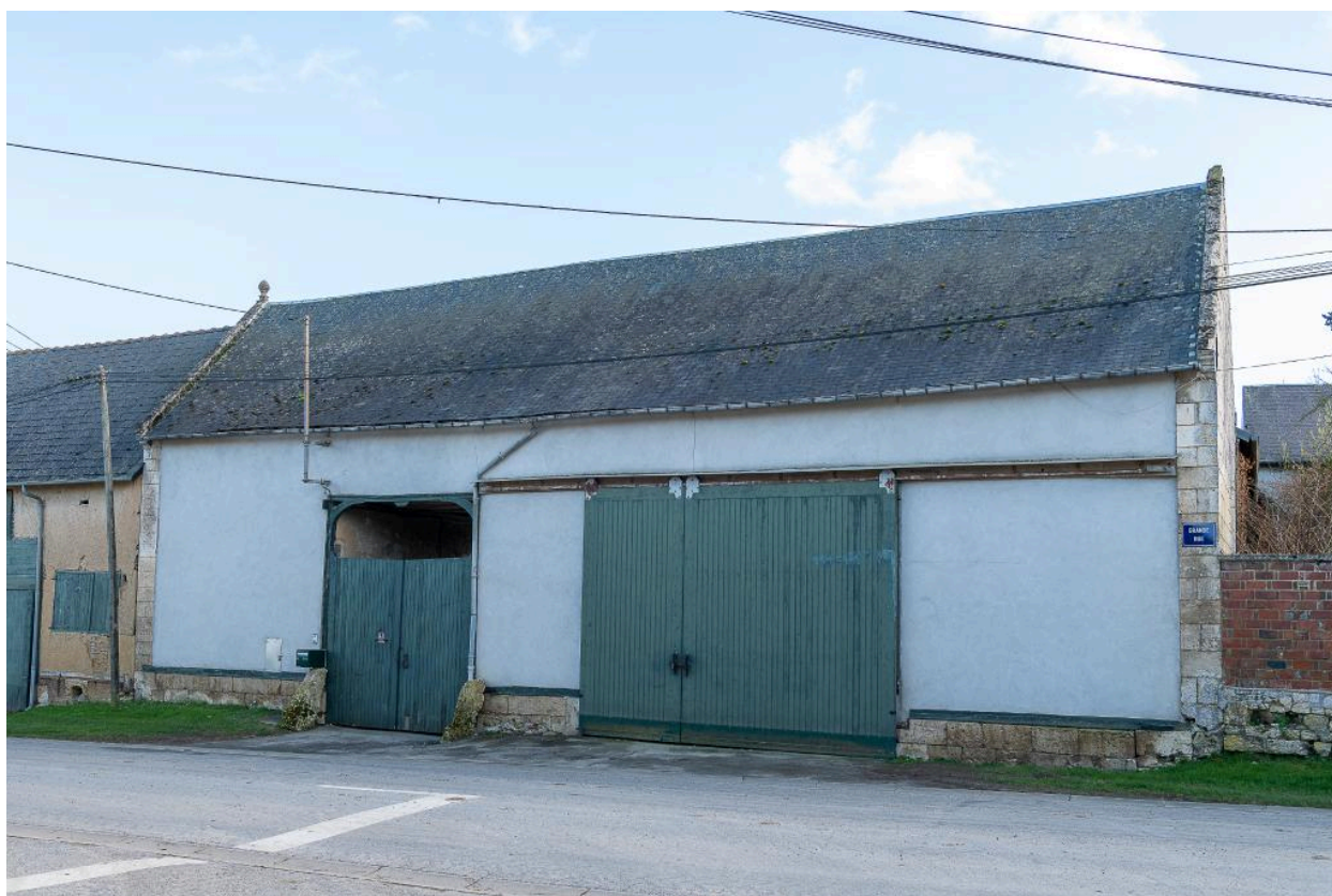
Grange sur rue avec entrée charretière, n°33 Grande Rue, vue depuis le nord.
