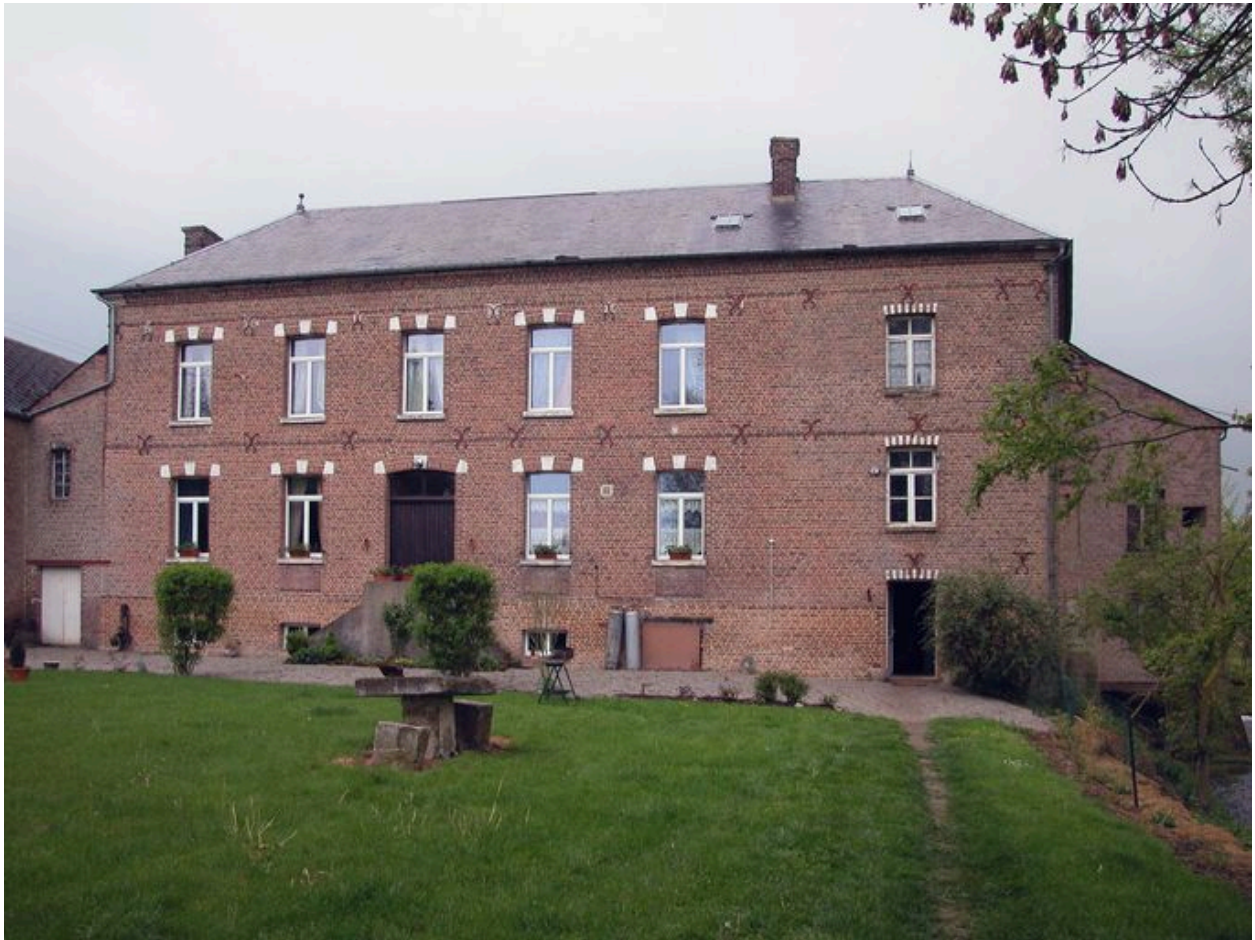
Façade sur jardin du logement patronal.
