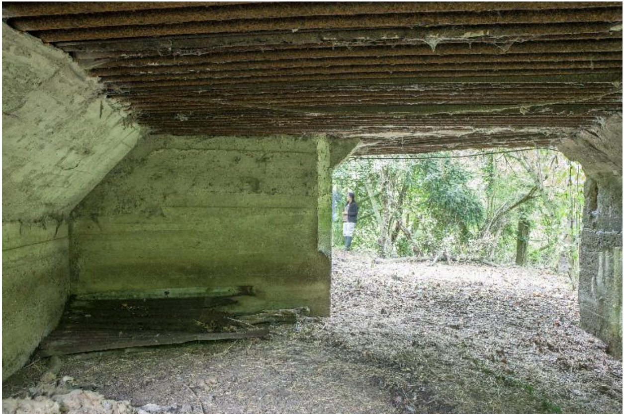
Sortie de la chambre de tir
