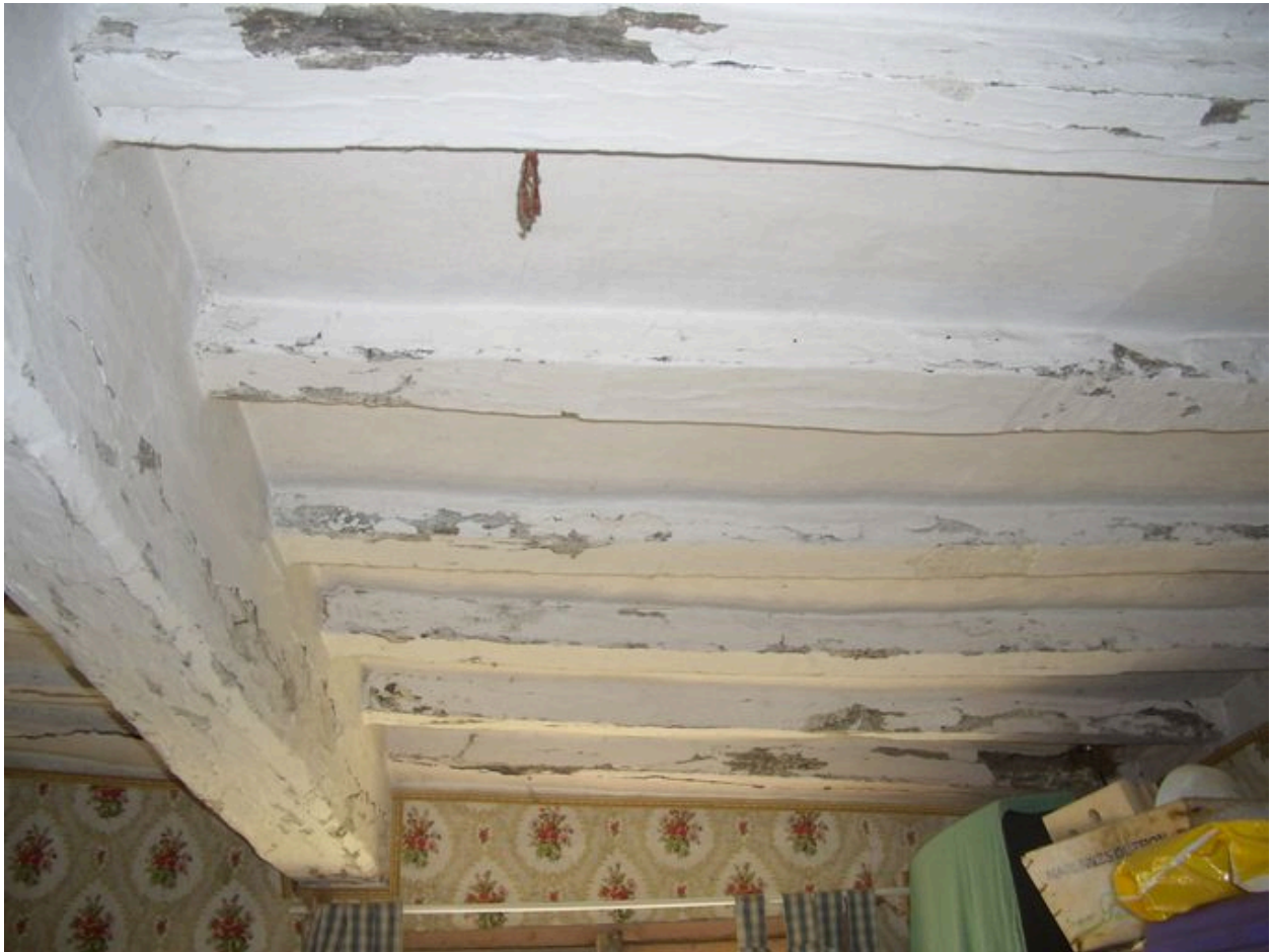
Vue du plafond de la chambre.
