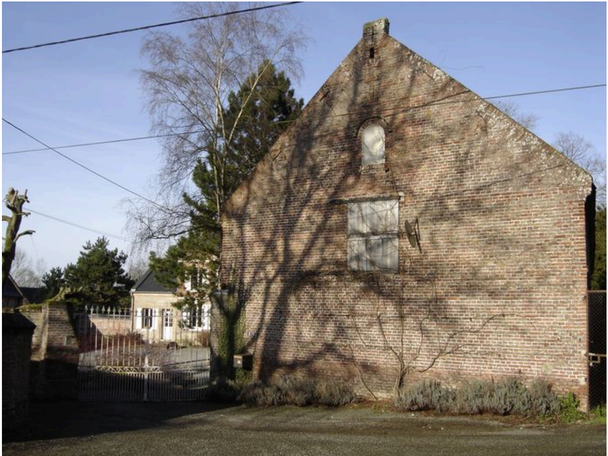
Vue du pignon des écuries depuis la rue.
