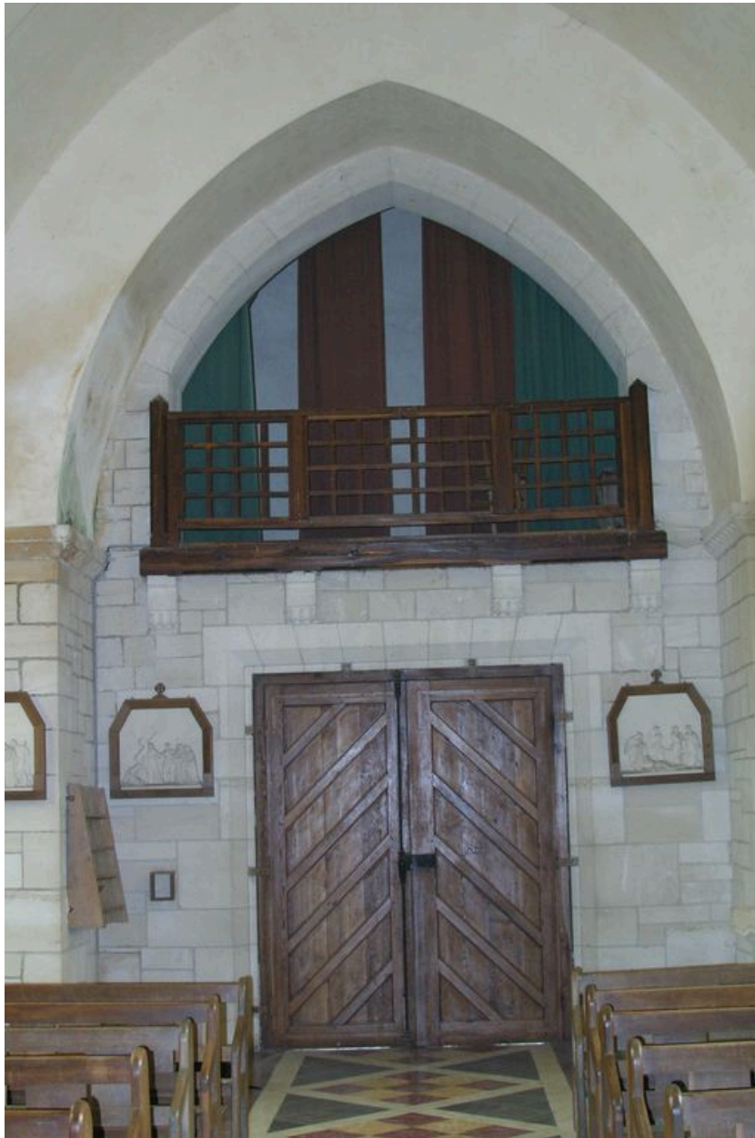
Vue de la porte ouest et de la tribune.
