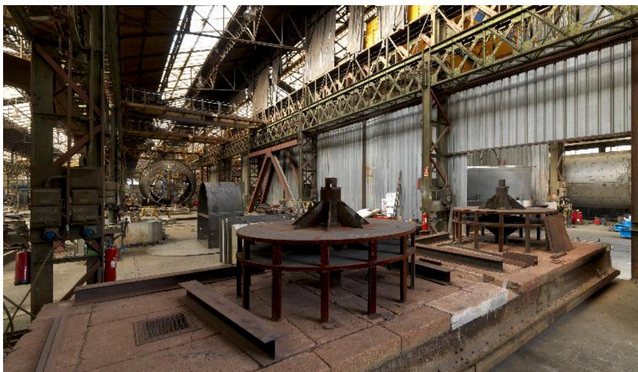
Atelier de chaudronnerie, vue d'ensemble vers l'ouest.
