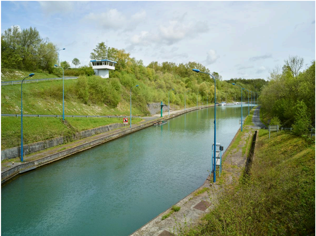
Tête nord, poste de commande et quai de stationnement de péniches.
