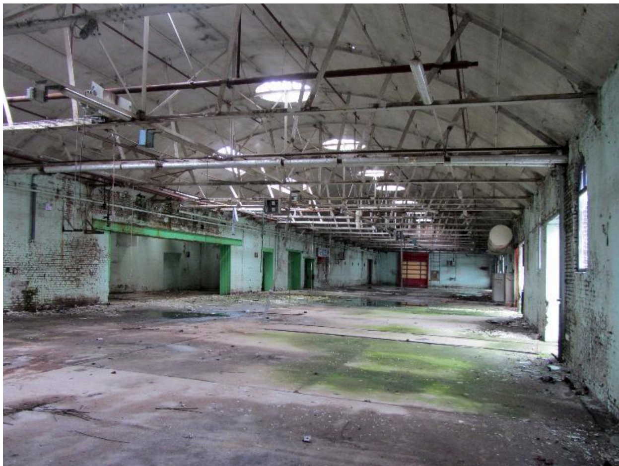
Vue d'ensemble du magasin à fil de jute.
