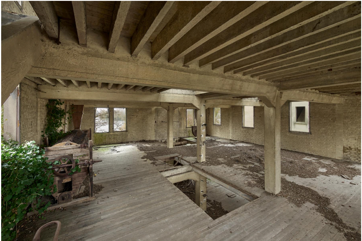
Intérieur du deuxième étage de la minoterie.
