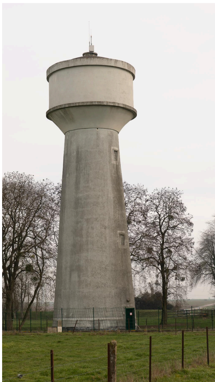
Château d'eau, rue des Lilas, vue prise depuis l'ouest.
