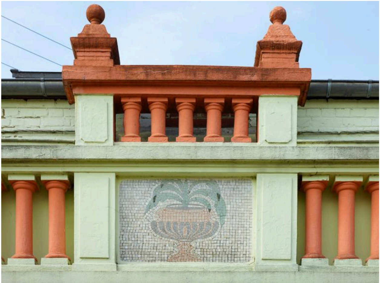
Détail du décor de la façade.
