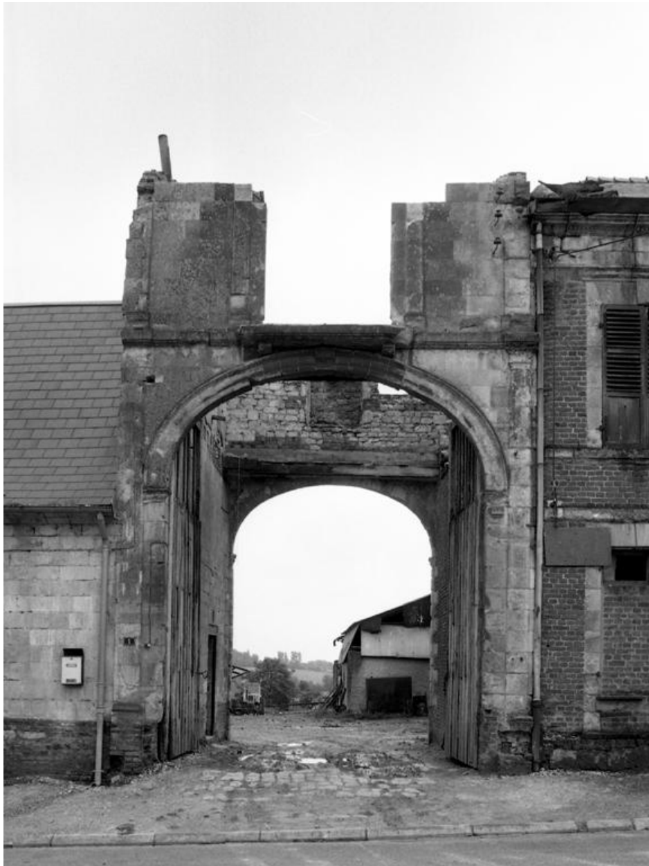
Vue de la façade du pigeonnier porche.
