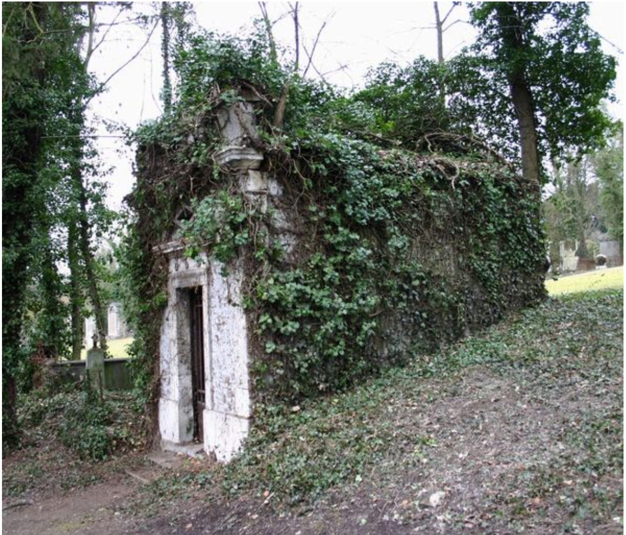
Vue générale, depuis le côté droit.
