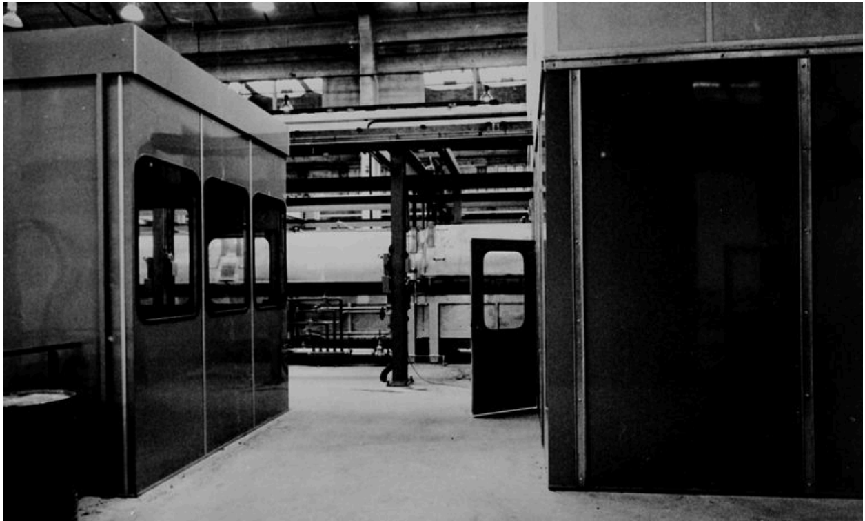
Atelier de fabrication : vue intérieure, vers 1925 (AP).
