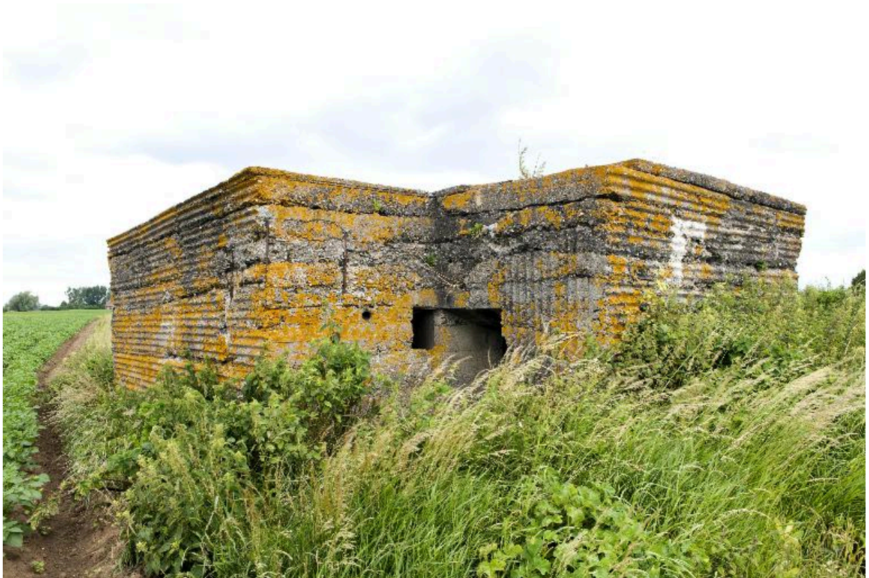
Vue de trois-quarts vers le nord. Entrée sud-ouest
