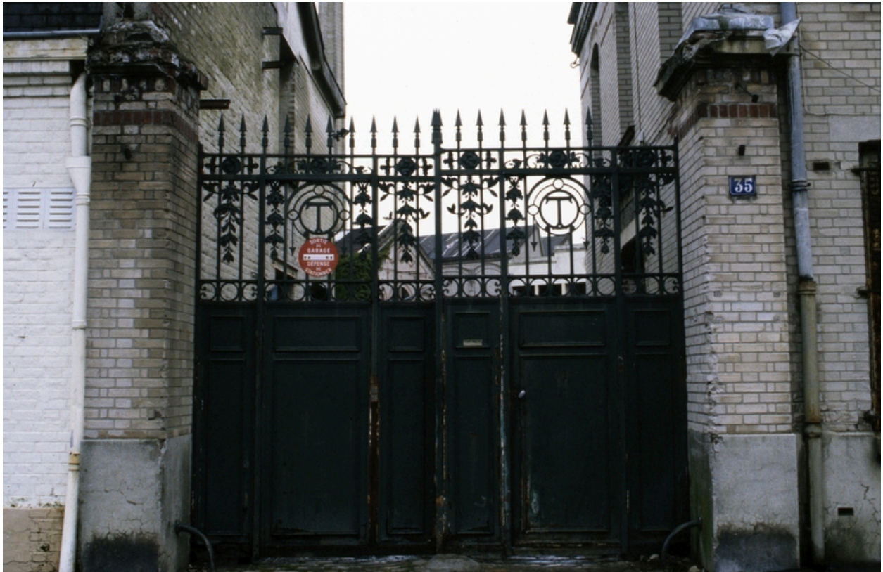
Grille en fer forgé de l'usine, 2001.
