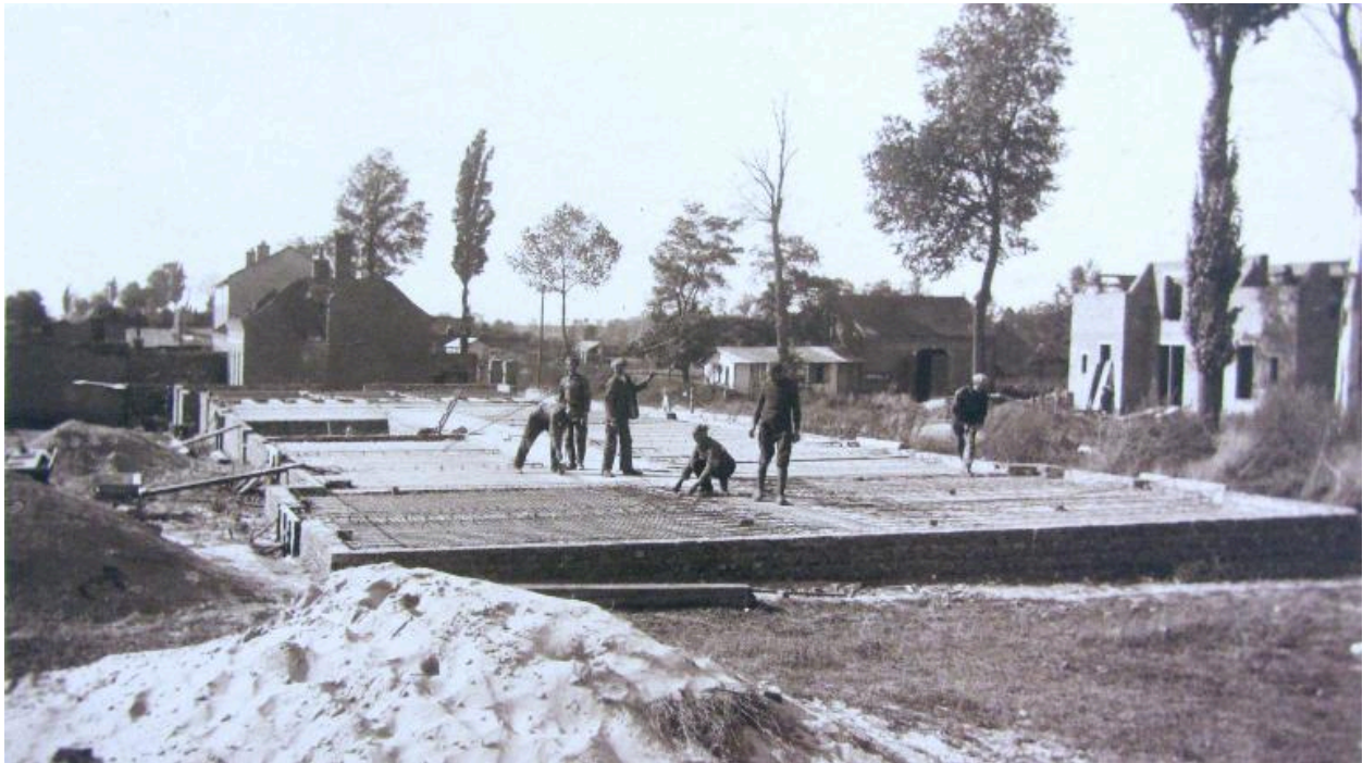
Pose de la dalle en béton armé du bâtiment de réfectoire de la sucrerie, 28 septembre 1920 (AD Somme ; 49 Fi 35).
