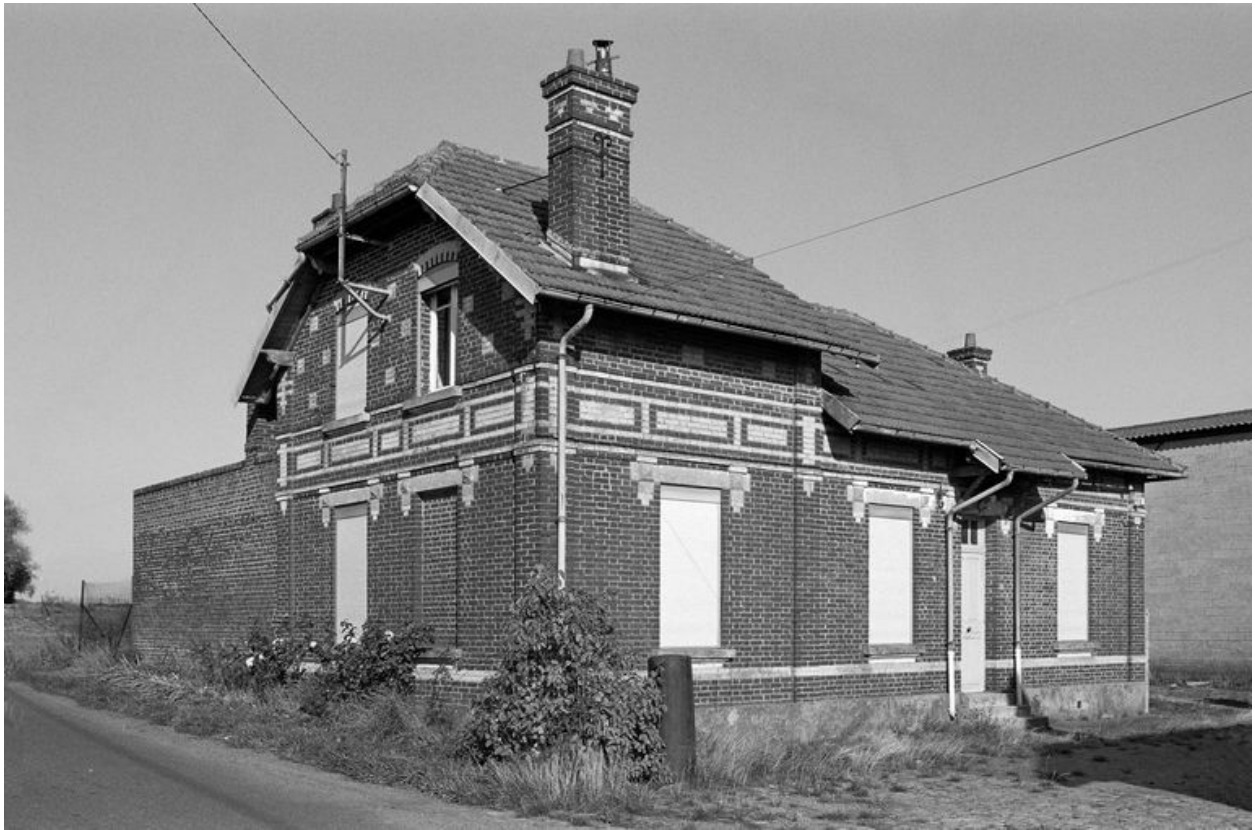
Logement de contremaître : flanc sud-ouest.
