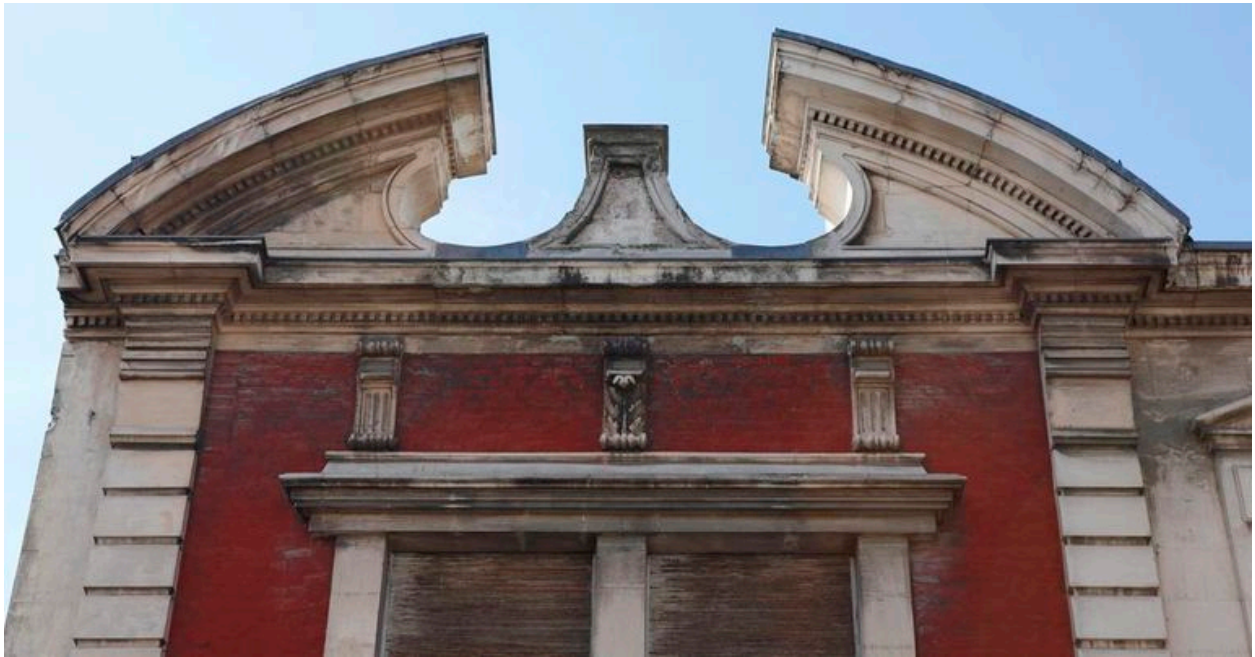
Vue sur le fronton curviligne interrompu.
