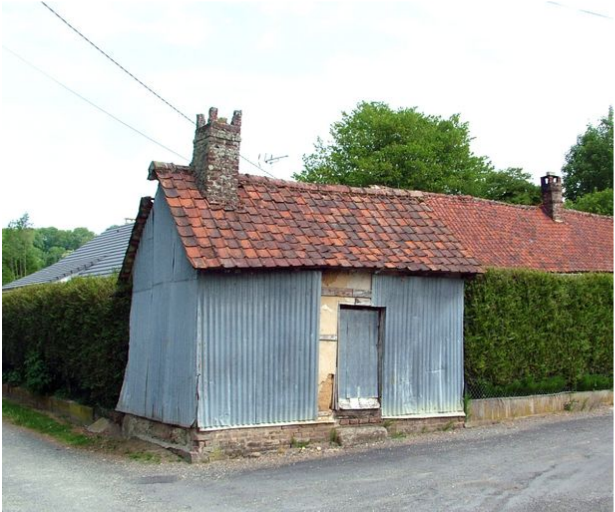
Vue du séchoir à chanvre depuis la rue.
