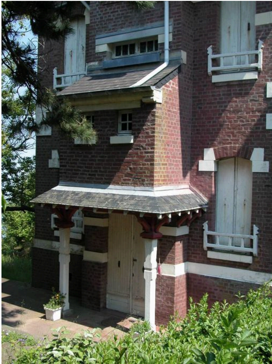
Détail du porche d'entrée.
