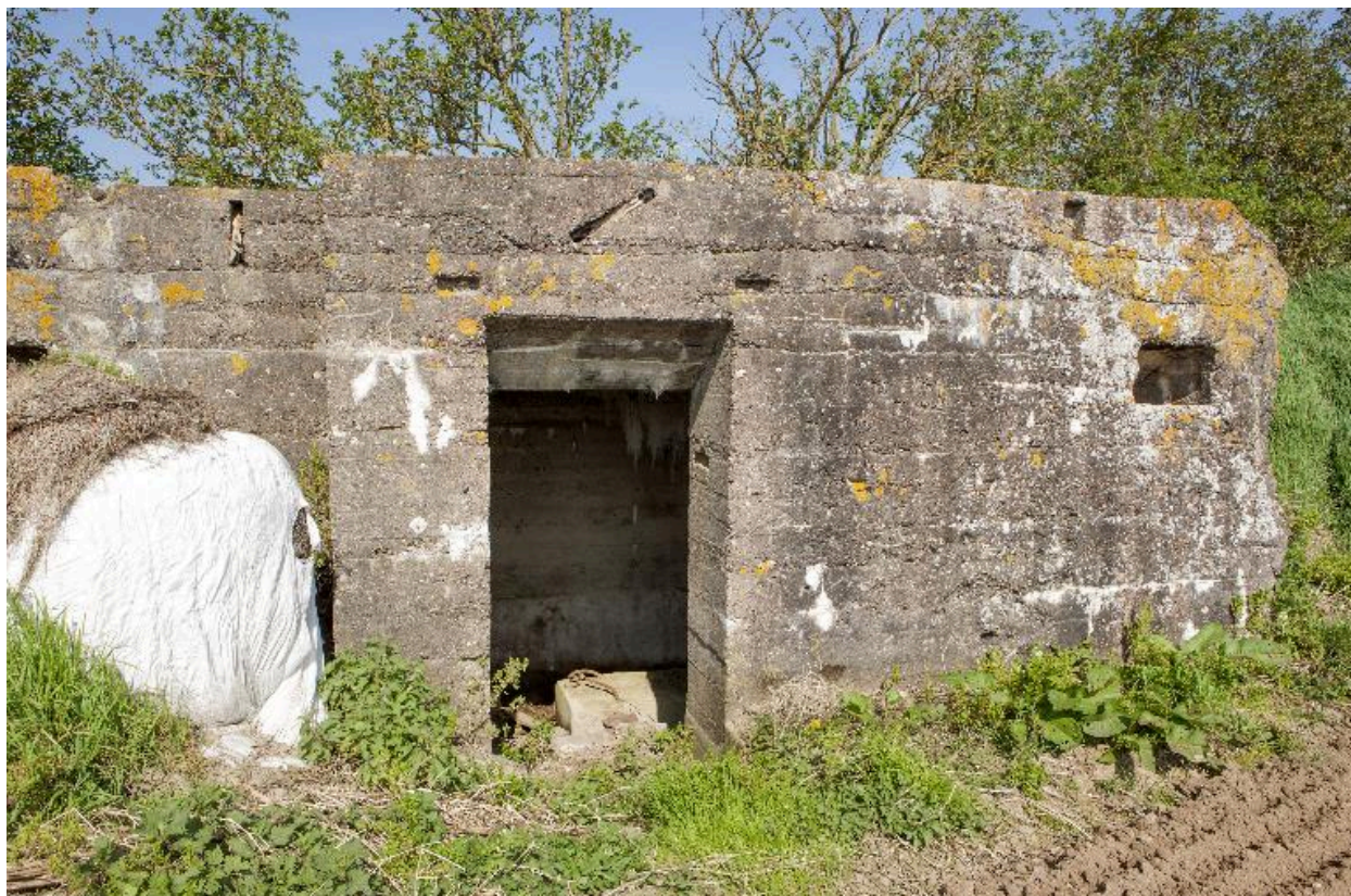
Bâtiment 2, élévation sud-est
