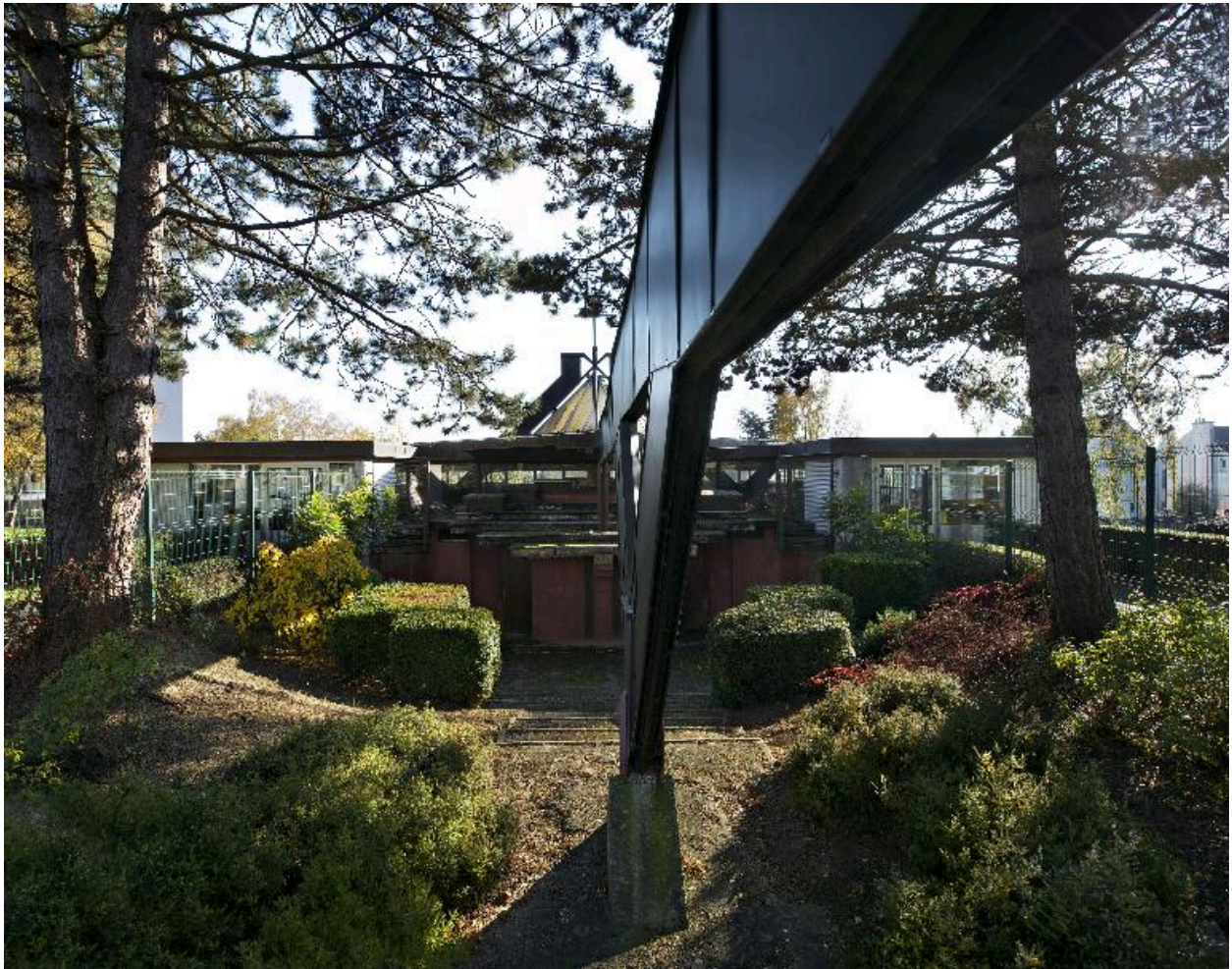
Vue depuis le nord. Accès à la chapelle de semaine et jardin.
