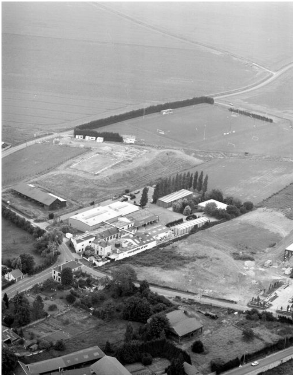
Vue aérienne de l'usine en 1994.
