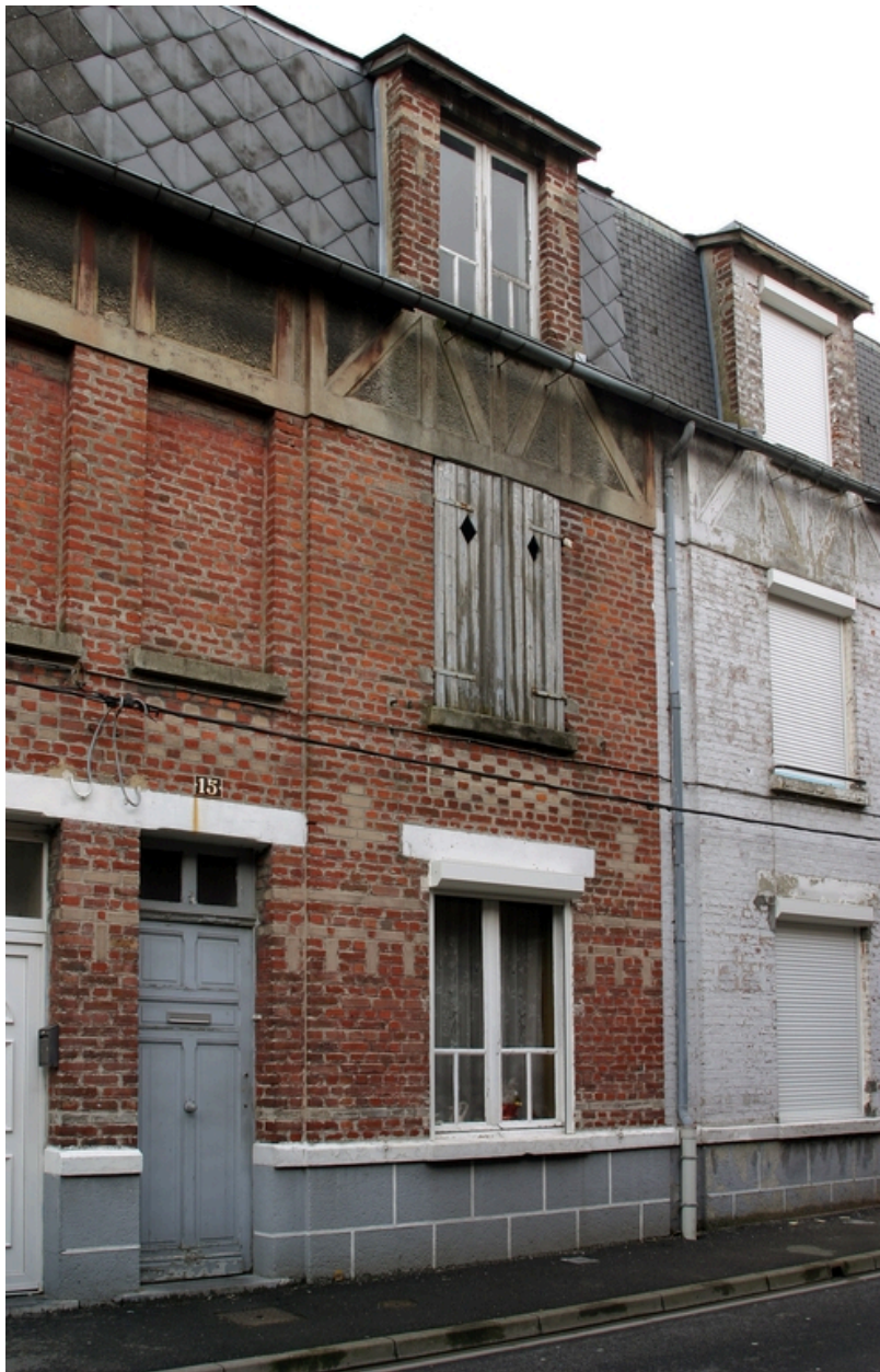
Façade de l'un des logements.
