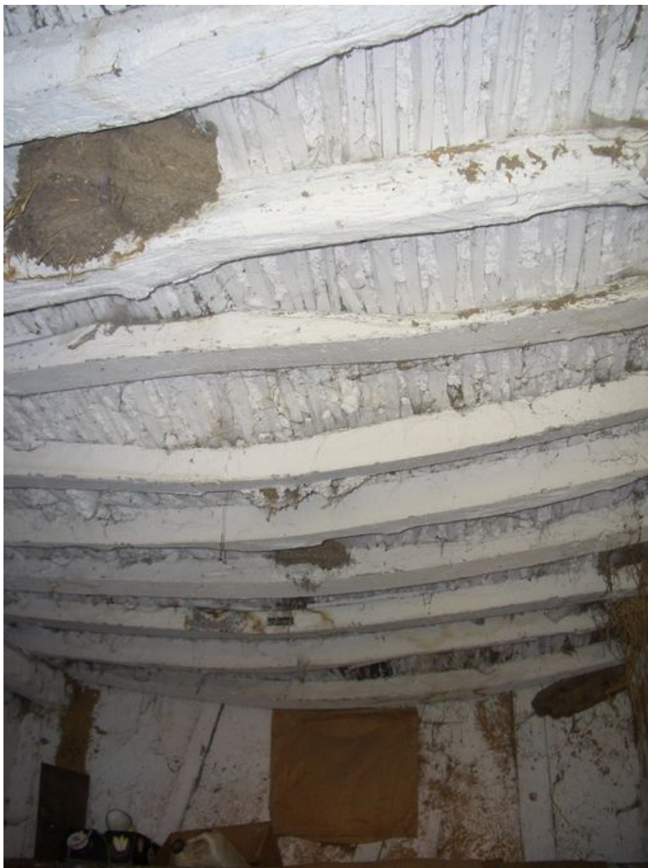
Vue détaillée du plafond d'une des écuries.
