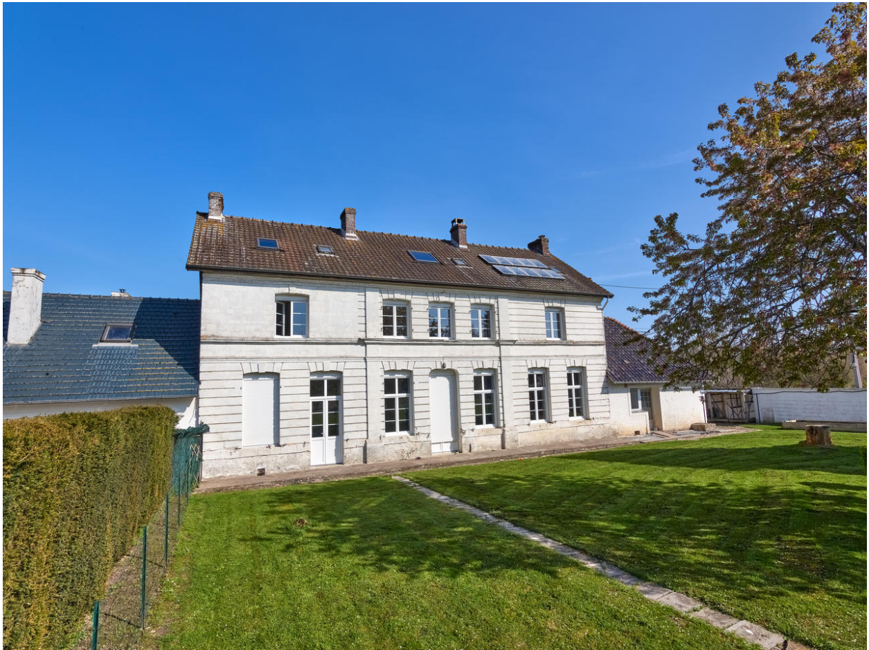
Vue de l'élévation sud depuis le sud-ouest.
