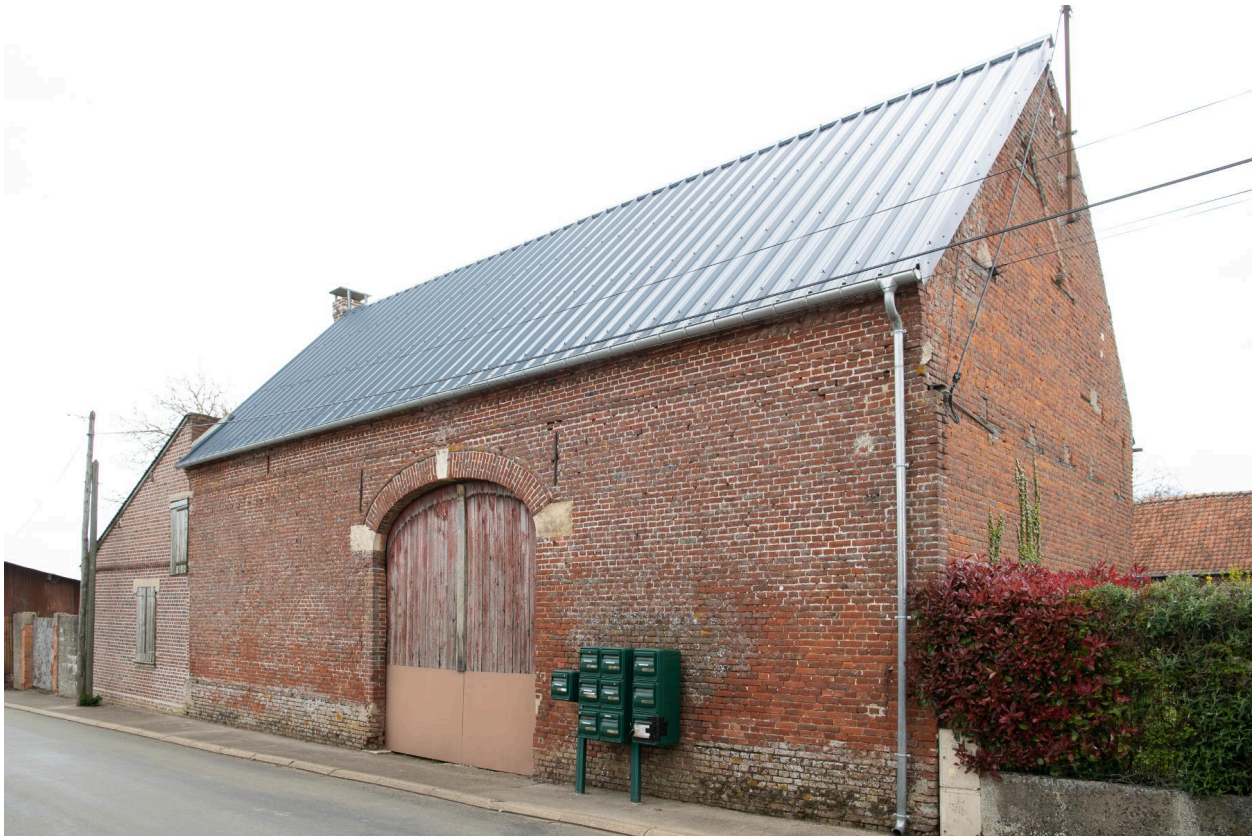
Grange reconstruite en brique, n°8 de la rue du Grand Cour, vue prise depuis le sud.
