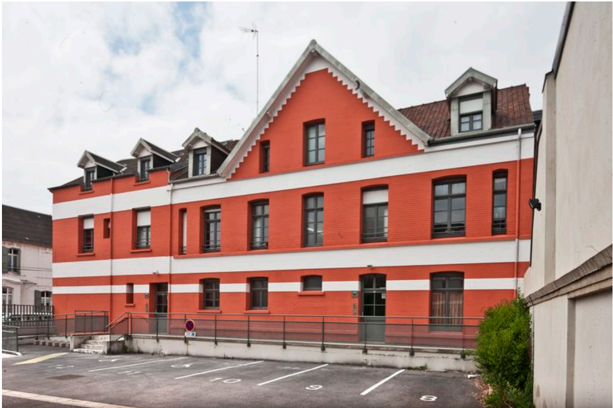
Vue générale de l'élévation postérieure de l'édifice donnant sur la rue Victor-Ménard.
